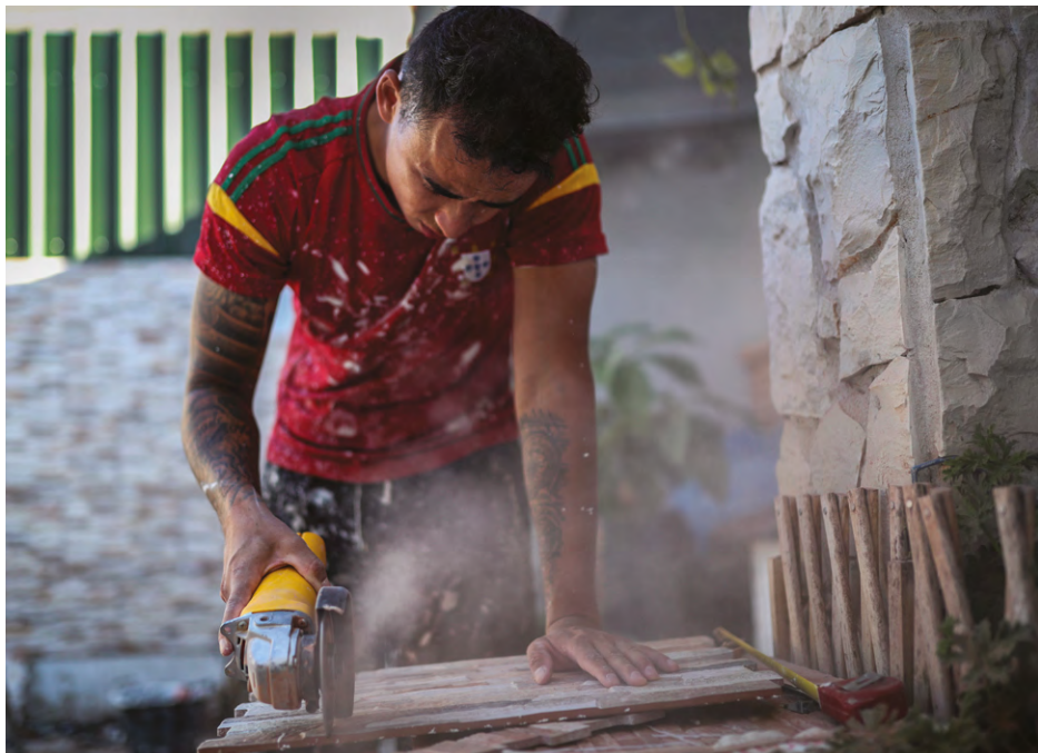
➤ Mlad muškarac radi na građevinskom projektu, Setúbal, Portugal, 5. kolovoza 2021.
